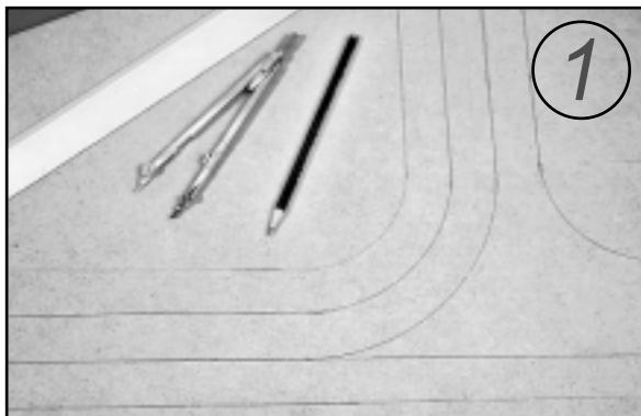
Zuerst wird der Verlauf des fahrzeuglenkenden Drahtes auf der Straßentrasse aufgezeichnet.
